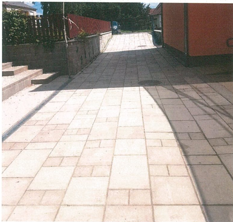
Térkövezés ,vízelvezetés kialakítása
