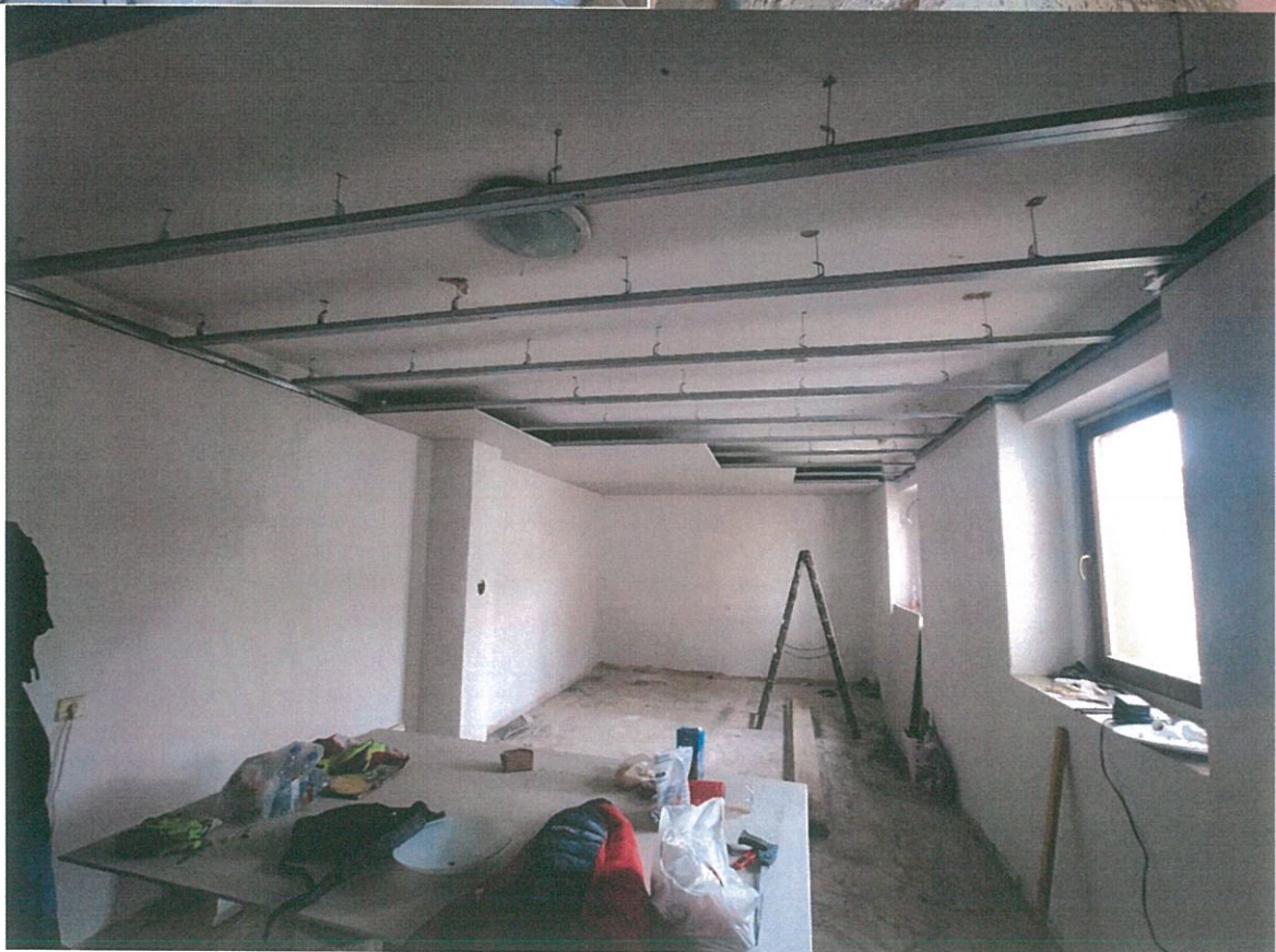
Vizesblokk és csoportszoba felújítás közben
