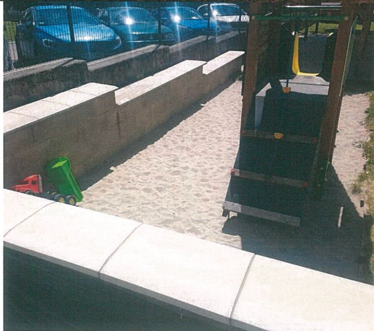
Az új bölcsődei csoportnak saját kis játszótér rész lett kialakítva az támfallal, és ütécscillapító homok telepítésével
